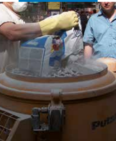
Maszynowe przygotowanie masy
