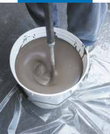
Przygotowanie masy za pomocą mieszadła
