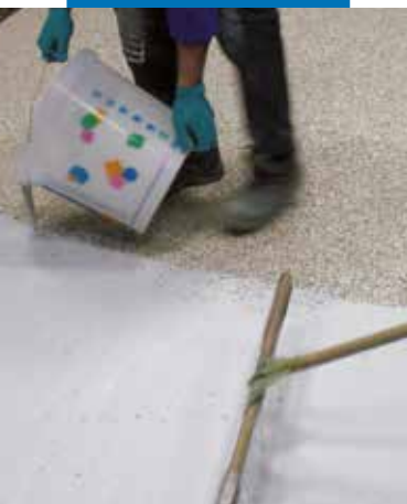
Aplikacja masy Ultratop na utwardzoną powierzchnię wykonaną z mieszanki kruszywa i Mapefloor I 910
