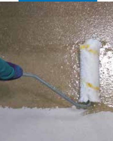
Nanoszenie Mapefloor I 910 w celu uzyskania efektu „terazzo alla Veneziana”
