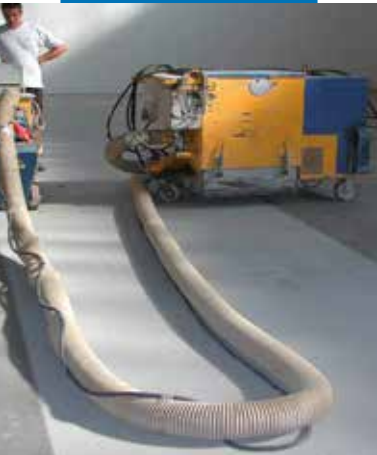
Przygotowanie podłoża przez obróbkę strumieniową ścierną
