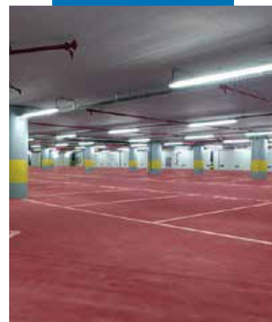
Posadzka z czerwonego Ultratop wykonana w pałacu Berlaymont w Brukseli
